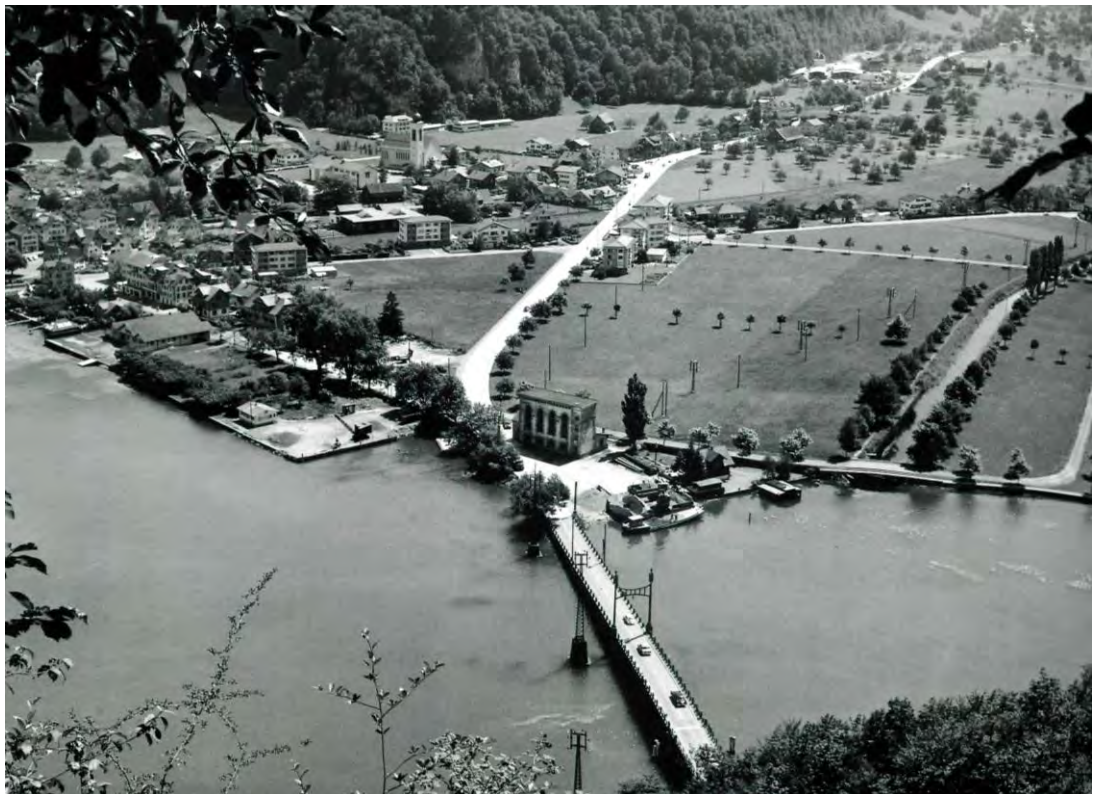
Abb. 2: Achereggbrücke in Stansstad 1960
